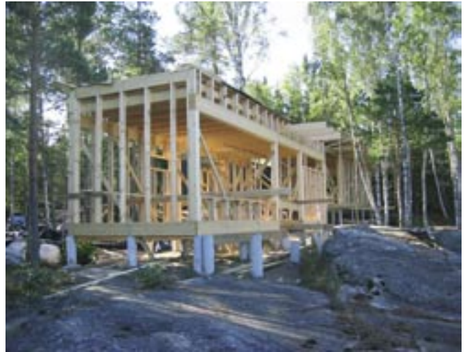
Puuosat toimitettiin pre-cut -pakettina työmaalle. Jokainen puuosa oli valmiiksi työstetty ja merkitty.
