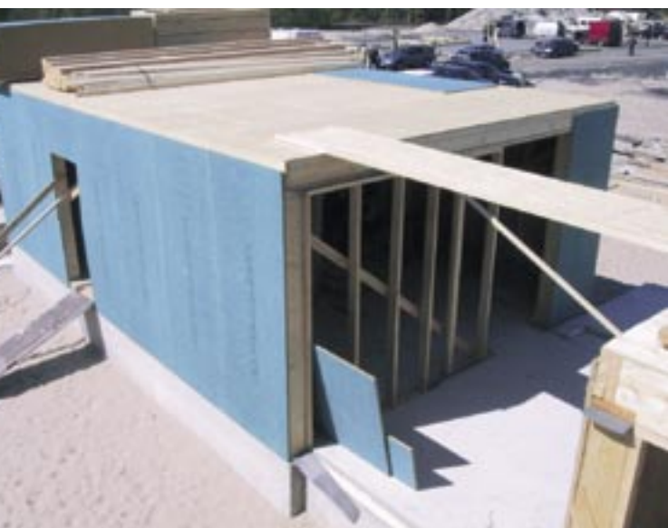
Valmis elementti nostetaan pystyyn.
