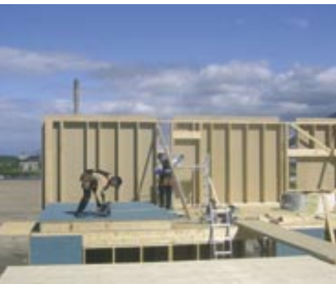
25 mm:n tuulensuojalevy jäykistää elementin.
