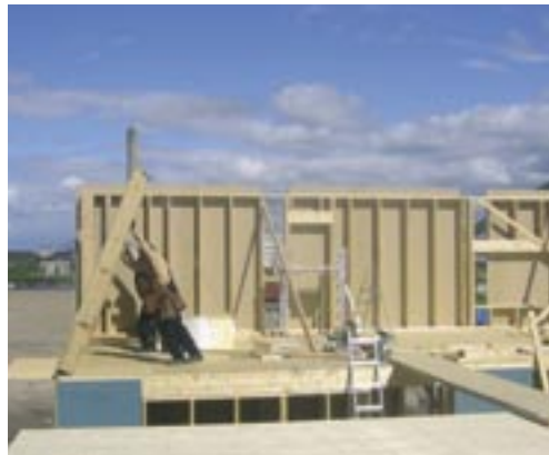
Seinäelementit kootaan valmiiksi katkotuista osista tason, platformin, päällä.
