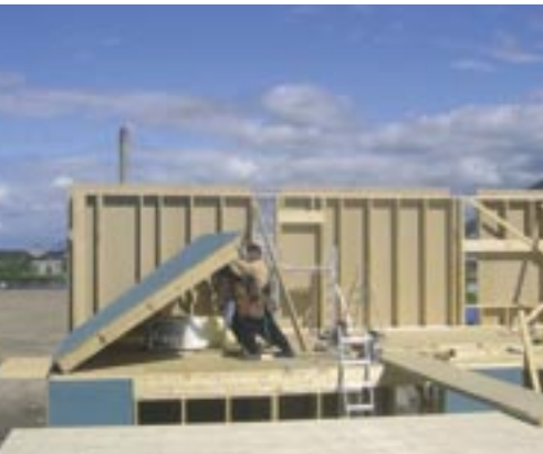
Valmis elementti nostetaan pystyyn.
