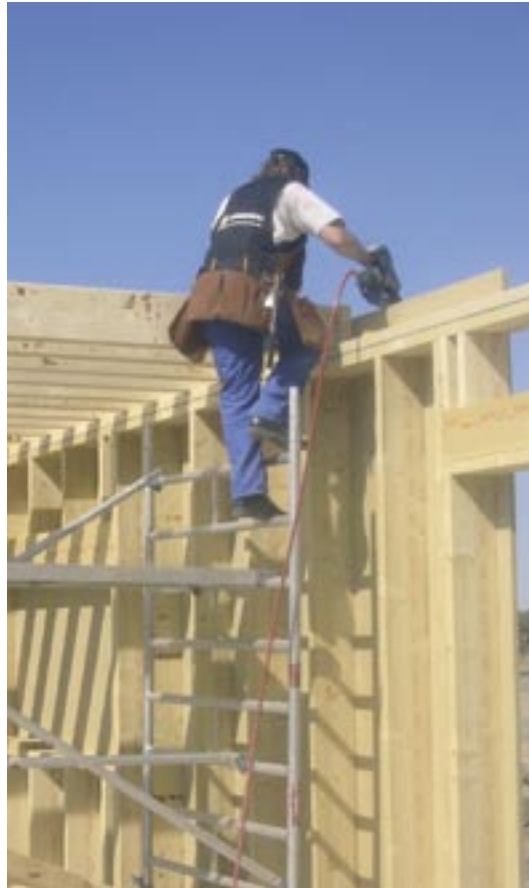
Seinäelementit tuetaan yläjuoksulla ja kehäpalkilla.
