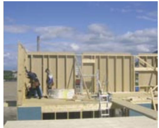
Elementti kiinnitetään alajuoksuun.
