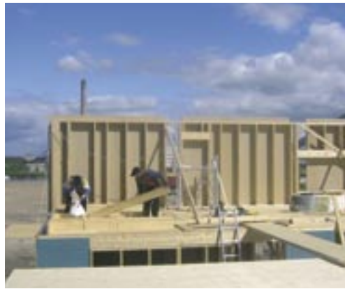
Seinäelementit kootaan valmiiksi katkotuista osista tason, platformin, päällä.
