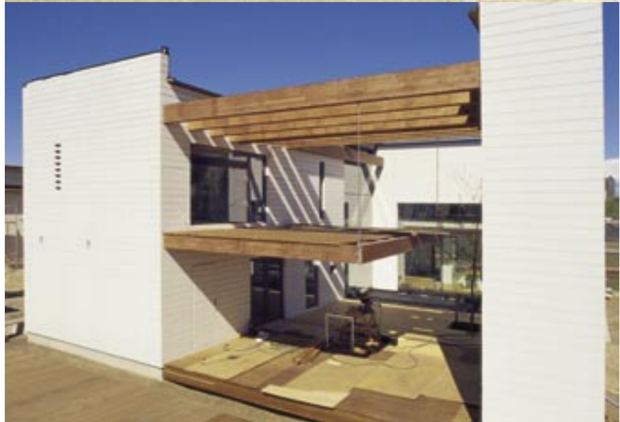
Julkisivut ovat leveää lautaa ja ulkorakenteissa kiinnittävät huomiota jyhkeät puupalkit.
