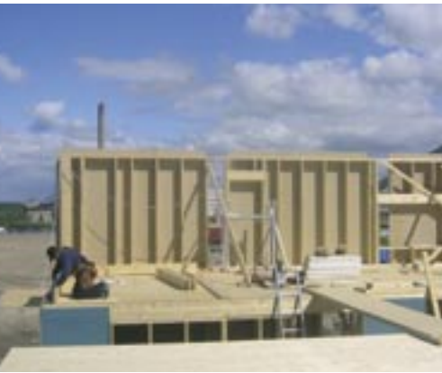
Seinäelementit kootaan valmiiksi katkotuista osista tason, platformin, päällä.
