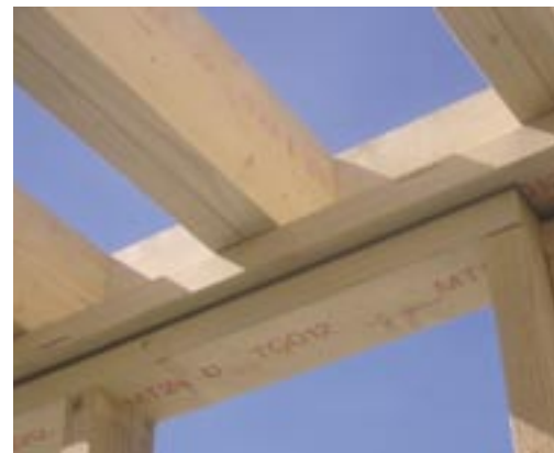
1. kerroksen seinä ja kehäpalkki
