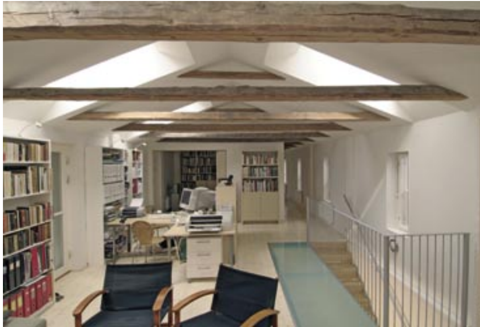
Yläkerran tiiliseinät ja puinen yläpohja lämmöneristettiin ja kattoon puhkaistiin ikkunat.
