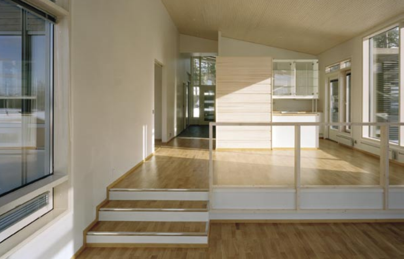
Vino sisäkatto ja suuret ikkunat tuovat ilmapuutaa sisätilaan. Valkolakatut ikkunaseinät asennettiin kertopuuelementteinä.
